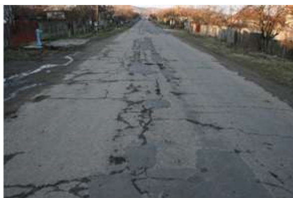
Situația existentă pe DJ 662
